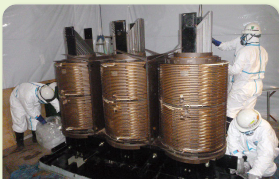
廃電気機器解体
