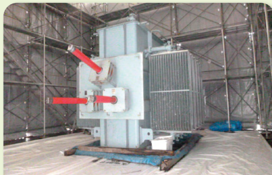
廃電気機器解体前
