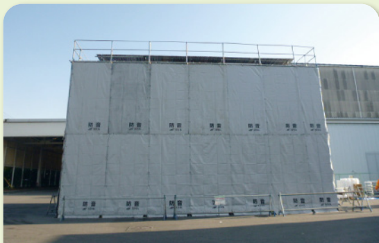
仮設解体建屋設置
