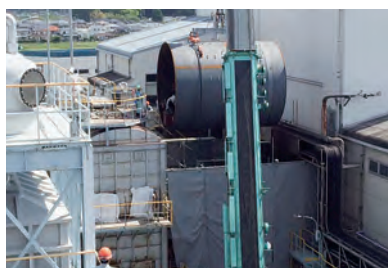
8号焼却炉ロータリーキルン交換
