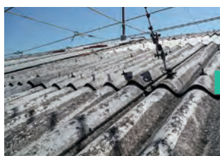
気密性向上対策(実施前) 壁・屋根にスキマあり(経年劣化、震災由来)
