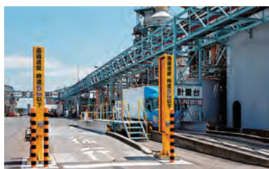
計量設備 計量設備わきの黄色い柱は放射線計測器です。持ち込まれる廃棄物は放射線を常時計測しています。
