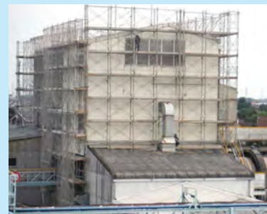
7号焼却炉汚泥ピット室気密性向上
