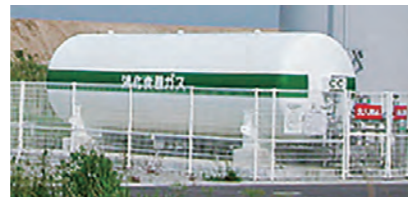
炭酸ガス注入設備
