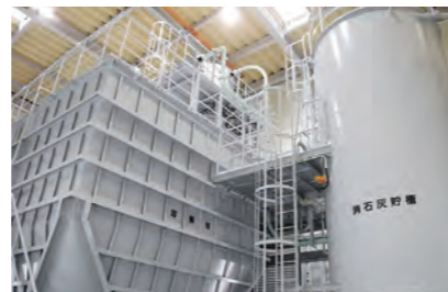
水酸化カルシウム溶液注入設備「オネストライマー」
