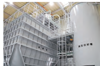
水酸化カルシウム溶液注入設備「オネストライマー」 (提供：唐津市久里浄水場)
