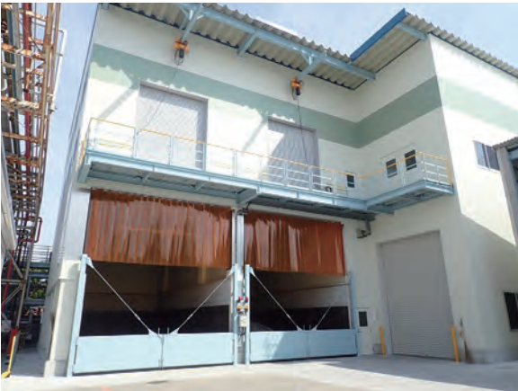
排水処理性能向上のため脱水機を増設しました。 (写真：増設した脱水機建屋)
