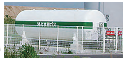
炭酸ガス注入設備 (提供：米子市戸上水源地)
