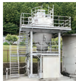
水酸化カルシウム溶液注入設備「オネストライマー」 (提供：唐津市久里浄水場)
