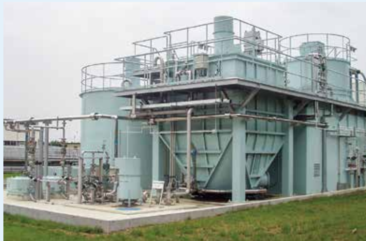
水酸化カルシウム溶液注入設備 (提供：東京都水道局 長沢浄水場)
