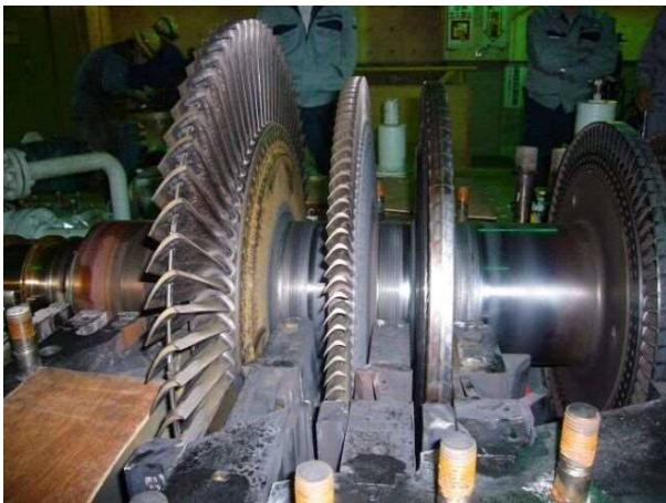
写真4 タービン開放点検
