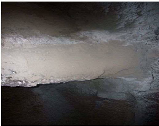
写真2 緊急修繕後の状態
