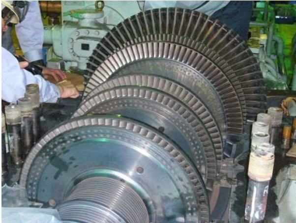
写真3 タービン開放点検
