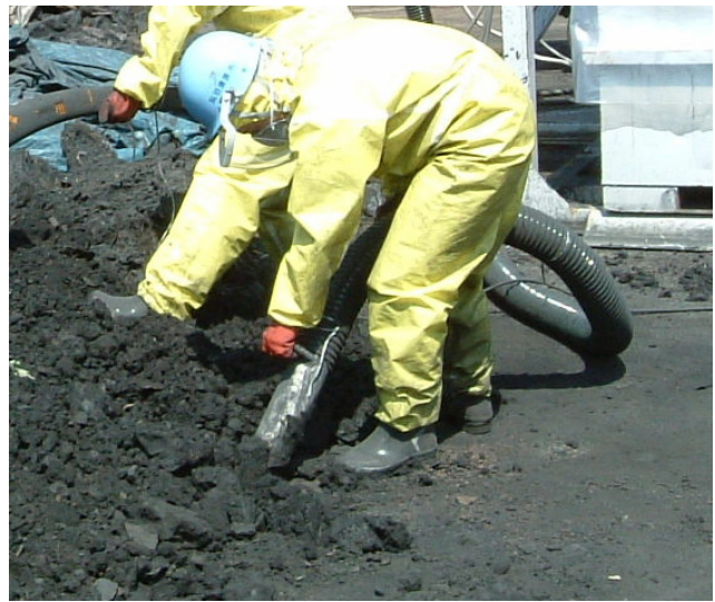
図-4 撤去作業状況
